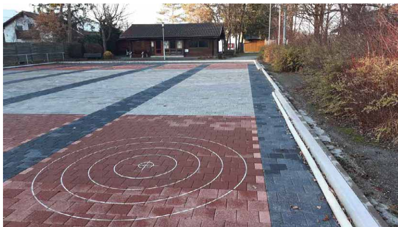
Unsere 2018 neu errichteten Pflasterbahnen im Betrieb
