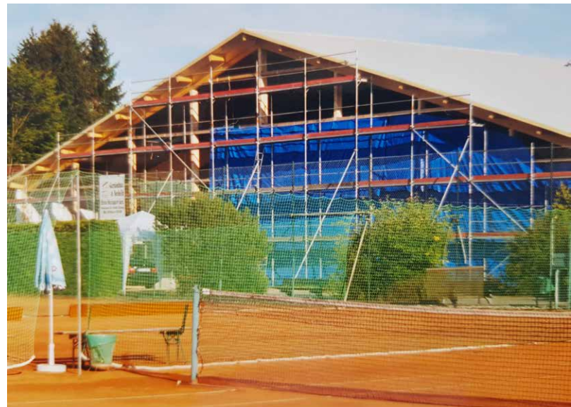
Bau der Tennishalle
